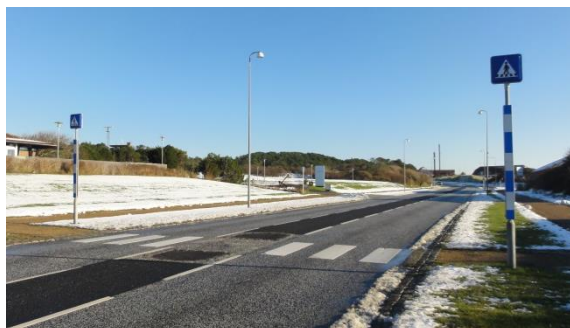
Figur 8-3. Fodgængerfelt på Chr. Hansens Vej uden kantstensafgrænsede midterheller (tv) og midterheller på Kystvejen (th).
